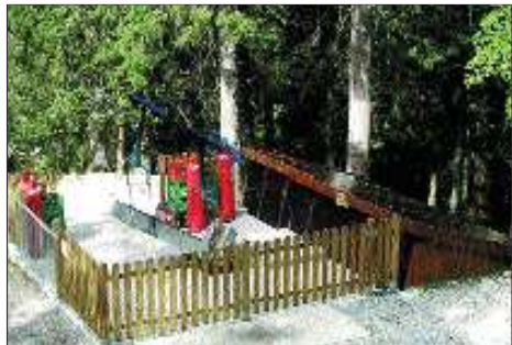
Die neu errichtete Talstation im Oktober 2001
