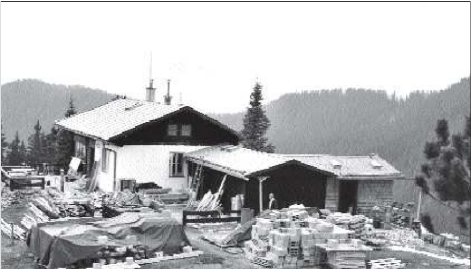
Die Großbaustelle Hochlandhütte im Jahr 1985
