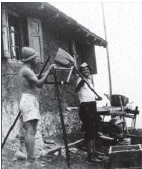
Bauarbeiten auf der Hochlandhütte
